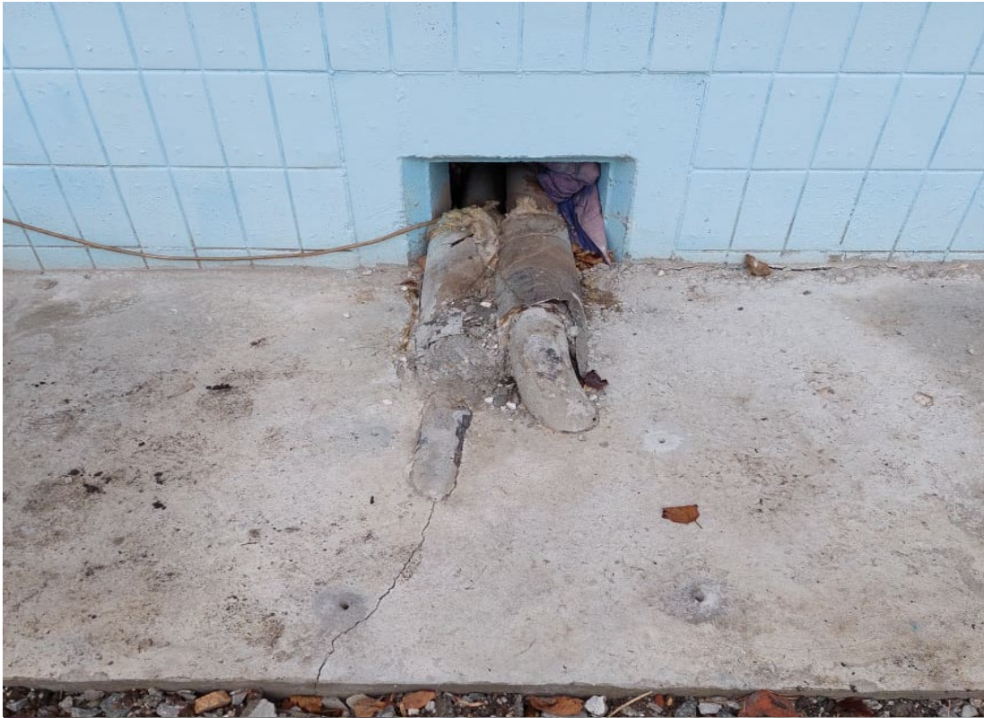
Монтаж защитного короба
